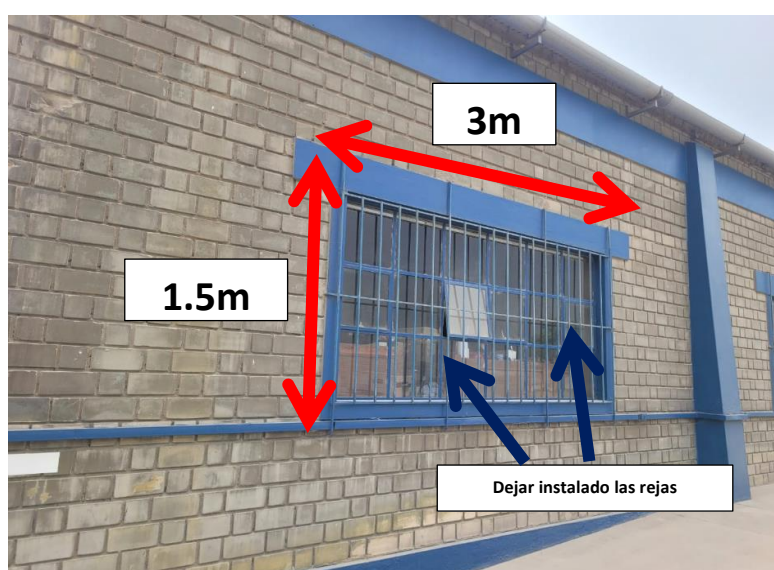
IMAGEN 1. Arreglo de ventanas N°01 a cambiar, las rejas de protección instaladas no se deben retirar, el cambio es solo las ventanas.
