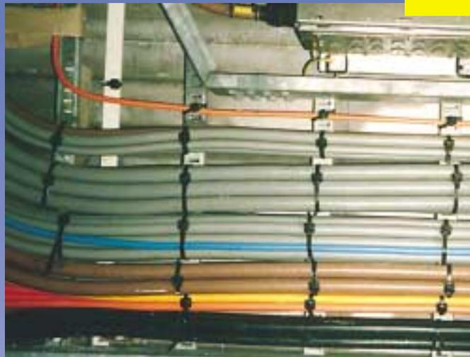
Los cintillos reutilizables BAND-IT, están recubiertos con nylon 11 para una mayor resistencia a la corrosión, como se muestra en esta aplicación de sujeción de un cable marino. El recubrimiento también protege al cable de daño o interferencia debido al contacto directo con el acero inoxidable.
