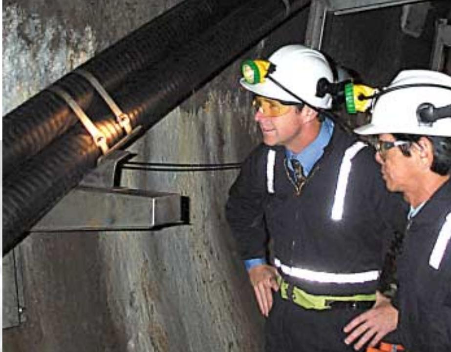
Un cable subterráneo en Nueva Zelanda es asegurado con las abrazaderas BAND-IT de acero inoxidable, a prueba de fuego
