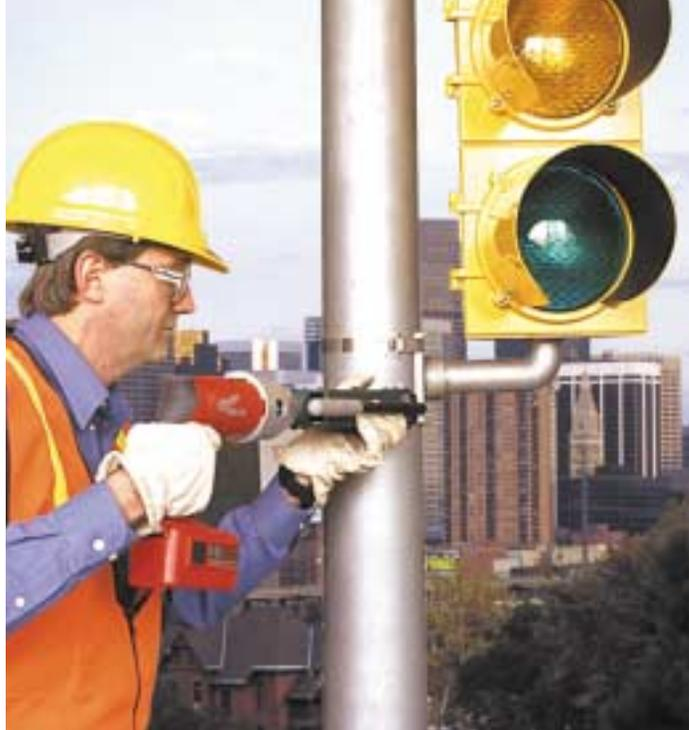
Las señales de tránsito se colocan rápida y fácilmente con las abrazaderas Ultra-Lok y con la herramienta UL2000 de batería recargable.
